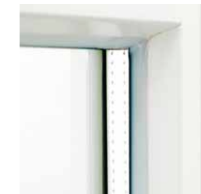
Det laminerede glas er limet i, så ruden ikke kan fjernes fra rammen
